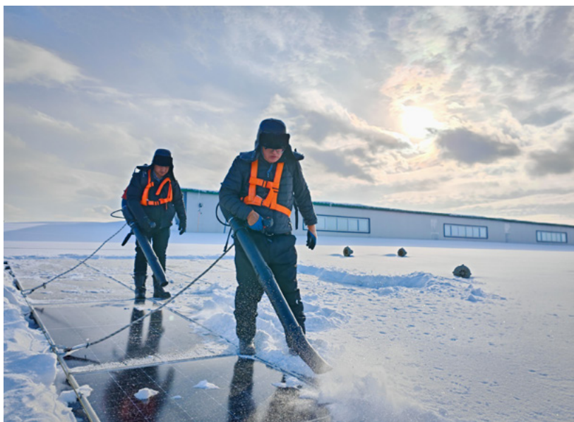
龙源电力黑龙江公司检修人员清理屋顶分布式光伏组件积雪
